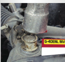
GOLPEAR LA TERMINAL Cerciórese de abrir bien las terminales al colocarlas en los postes, evite golpes con cualquier otro objeto.
