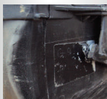
GOLPEADA Cuando la batería no está bien sujeta a la base o bien por impacto o choque.
